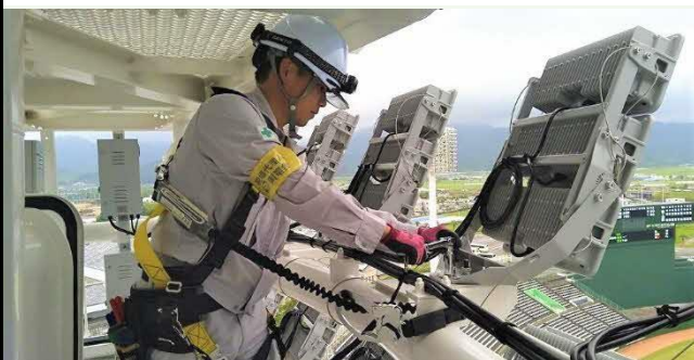
【電気工事作業風景】
