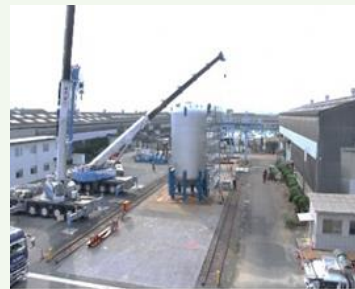
【大物タンクの搬出作業】
